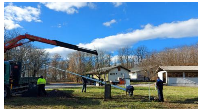
Postavljanje temeljnog bloka i stupa za meteorološku postaju
